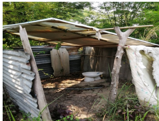
นายงยุทธ ห้องน้ำก่อนปรับปรุง
